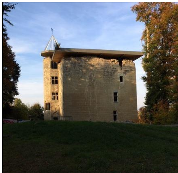
Etat actuel en cours de travaux de conservation
