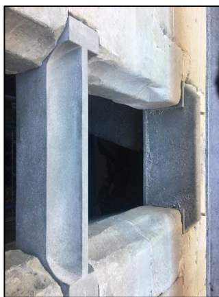
Les orifices sont consolidés et assainis
