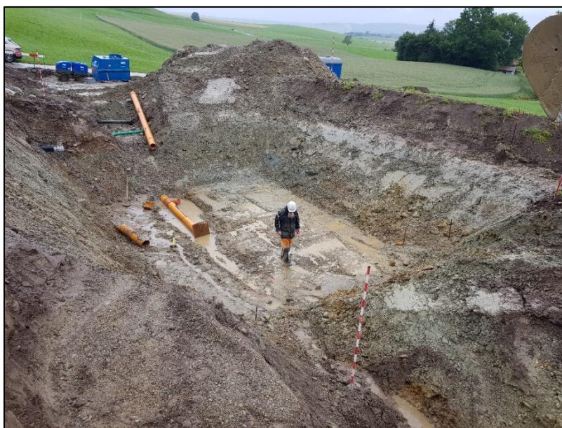
Terrassement effectué au 09.02.2020
