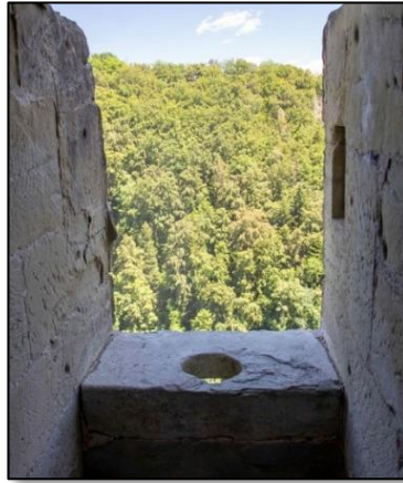
Détails d'une latrine en ouverture sur la façade Est
