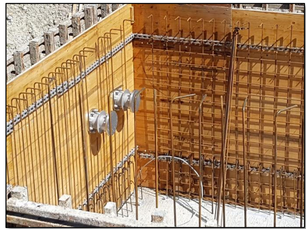
Traversées murales en acier inox avec collerette d'étanchéité
