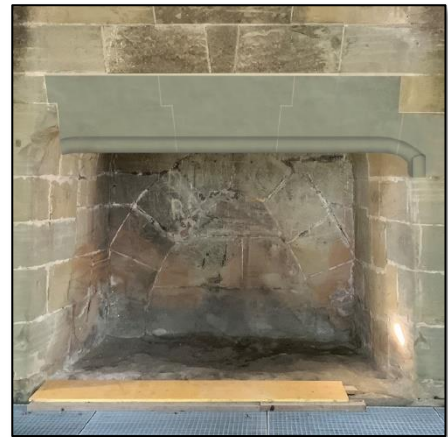
Détails des travaux de conservation d'un manteau de cheminée
