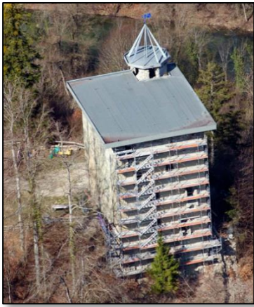
La façade Est en cours de travaux
