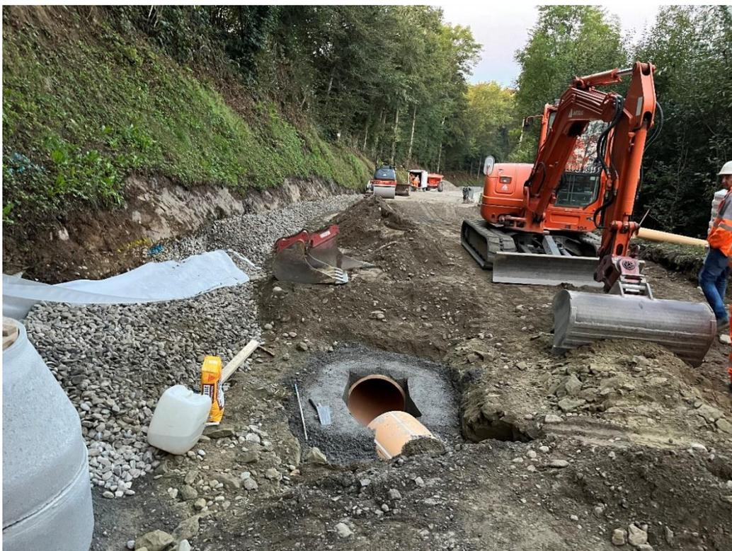
Le chantier de la route de Fribourg à Farvagny-le-Petit est en cours et permet de mettre en place un réseau d'eaux usées et eaux claires en prévision de la mise en séparatif du secteur.
