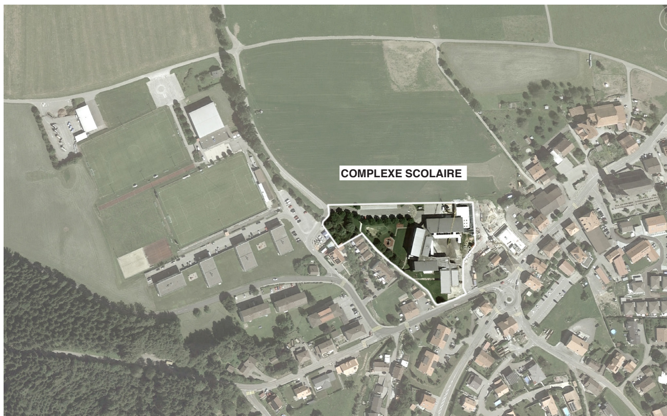
POLE SCOLAIRE DE FARVAGNY-LE-GRAND_GOOGLE MAPS
